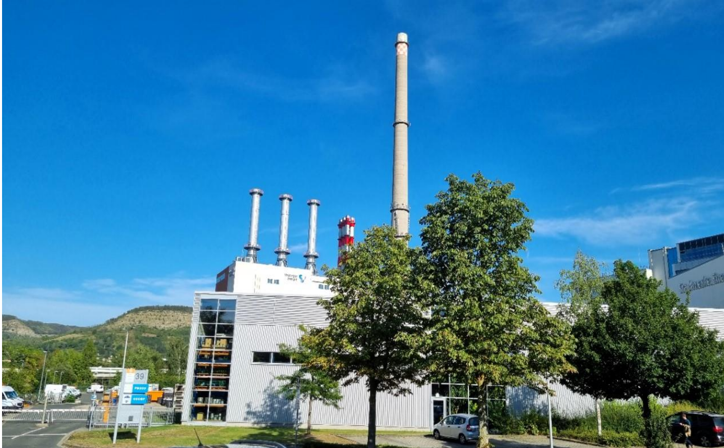
Das Gaskraftwerk in Jena beliefert > 200 Großkunden der Stadt mit 95°C – 120°C Wasser.
